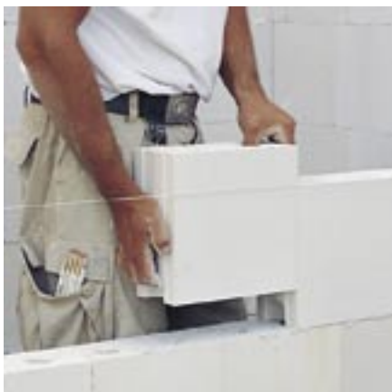
Versetzen der Steine
