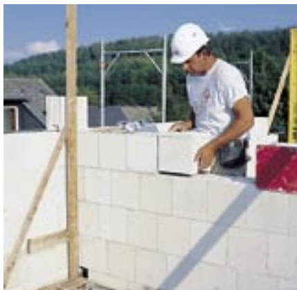
Versetzen der Steine
