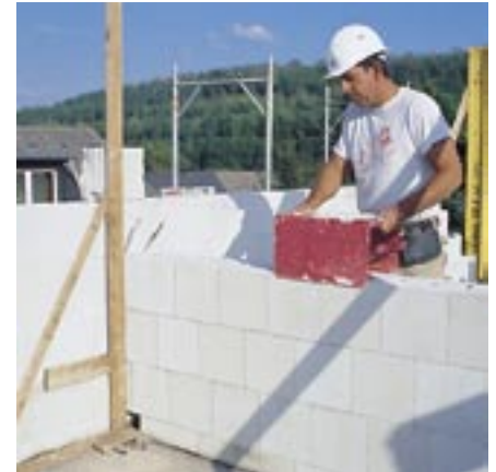
Aufziehen des Dünnbettmörtels mit dem Mörtelschlitten
