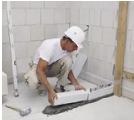
Anlegen der Kimmschicht in Normalmörtel...
