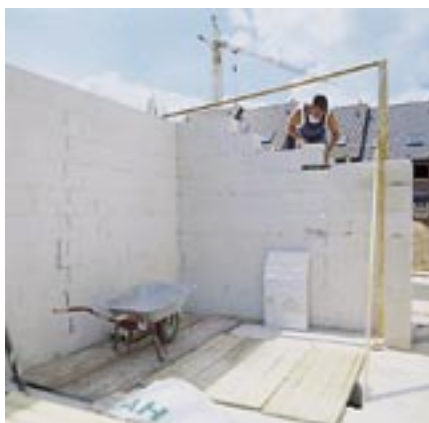
Arbeiten mit Hilfe einer Mauerlehre
