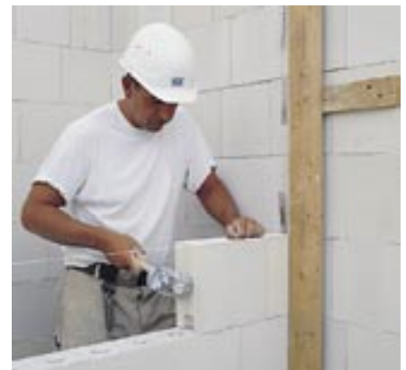
Steine nach Schnur ausrichten
