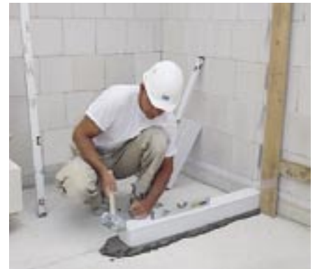
... zum Ausgleich von Unebenheiten der Bodenplatte
