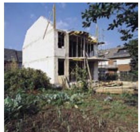
Der fertige Rohbau
