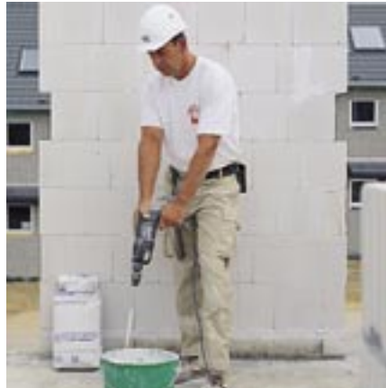
Anmischen des Dünnbettmörtels
