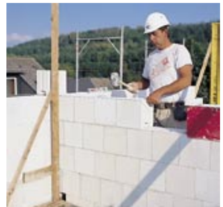
Ausrichten der Steine
