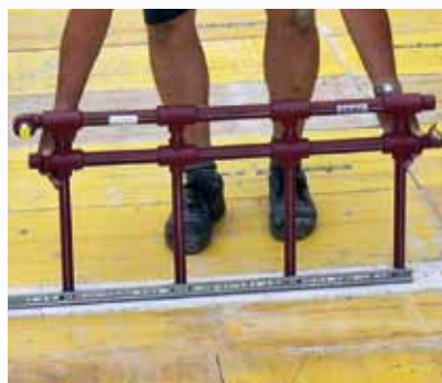
Einfädeln des Temperierungsmoduls
