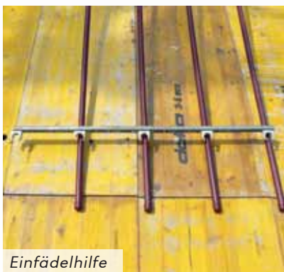
Einfädeln des Temperierungsmoduls
