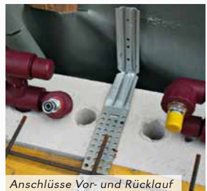
Einfädeln des Temperierungsmoduls
