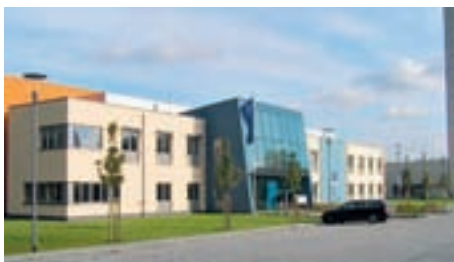
Ansicht aus Nordwest.
