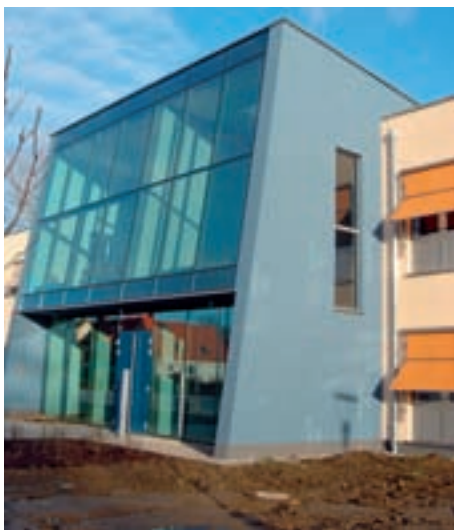
Mittelpunkt ist das rund 2 000 m 2 große Labor- und Bürogebäude. Bilder: Bio Con Valley
