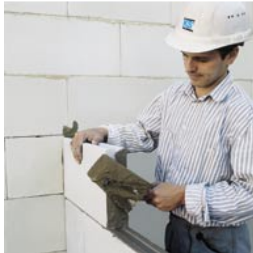
Bild 21: Stumpfstoß einer leichten Trennwand aus KS-Bauplatten
