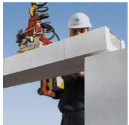
Bild 31: KS-Flachsturz
