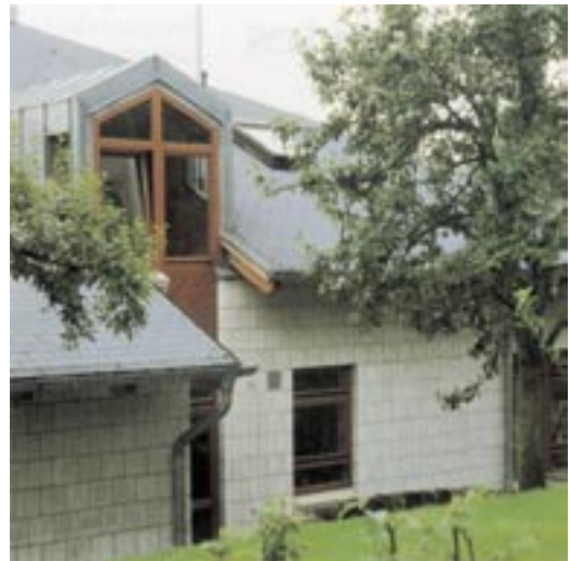
Bild 1: Kalksandstein-Fassade mit Verblendern
