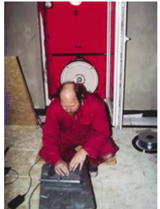
Bild 6: Mit dem Blower-Door-Test wird die Luftdichtheit geprüft.
