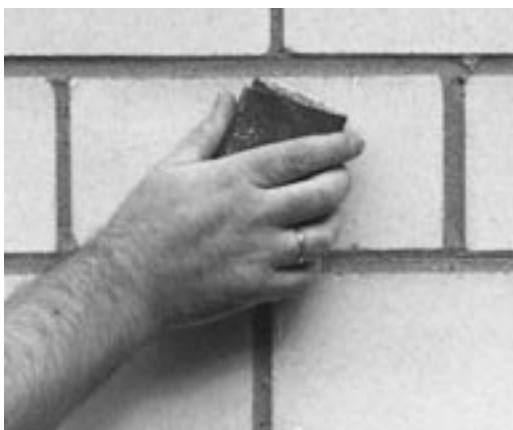
Bild 49: Schonende Reinigung mit Sandpapier, feinste Körnung
