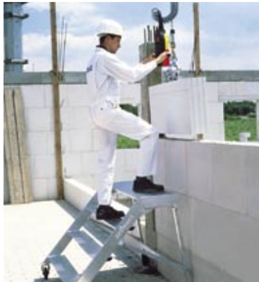
Bild 39: Versetzen von KS XL
