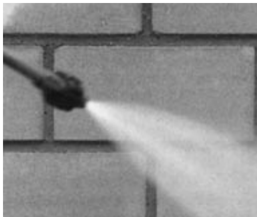
Bild 48: Reinigung mit Dampfstrahlgerät
