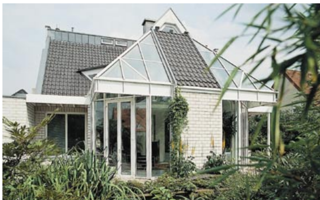
Kalksandstein speichert Sonnenenergie und gibt als KS-Verblendmauerwerk zusätzliche Gestaltungsmöglichkeit.
