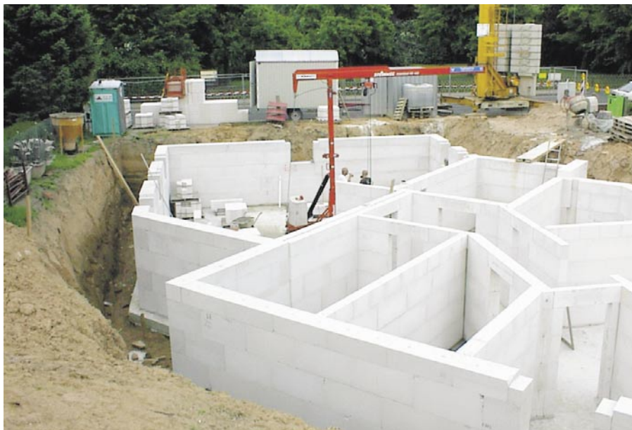
Bild 1/1: Keller aus Kalksandstein sind für alle Abdichtungsarten geeignet.
