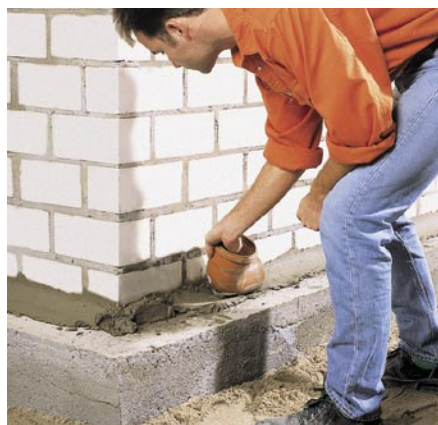
Bild 6/4: Herstellen der Hohlkehle; Querschnittsabdichtung mit Dichtschlämme
