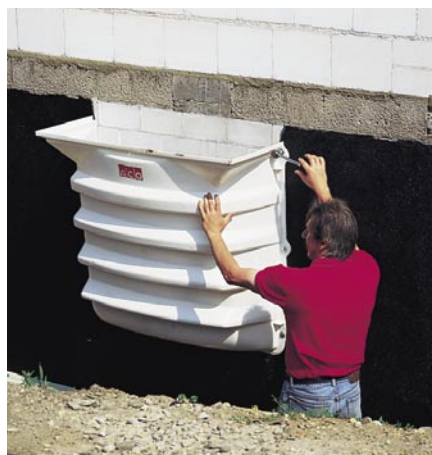
Bild 3/10: Lichtschächte werden meist als Fertigelemente verwendet.
