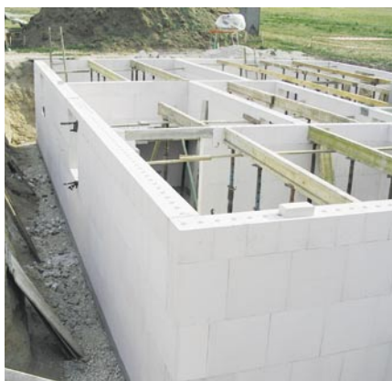
Bild 4/5: Kalksandstein-Mauerwerk ist für den Kellerbau bestens geeignet.
