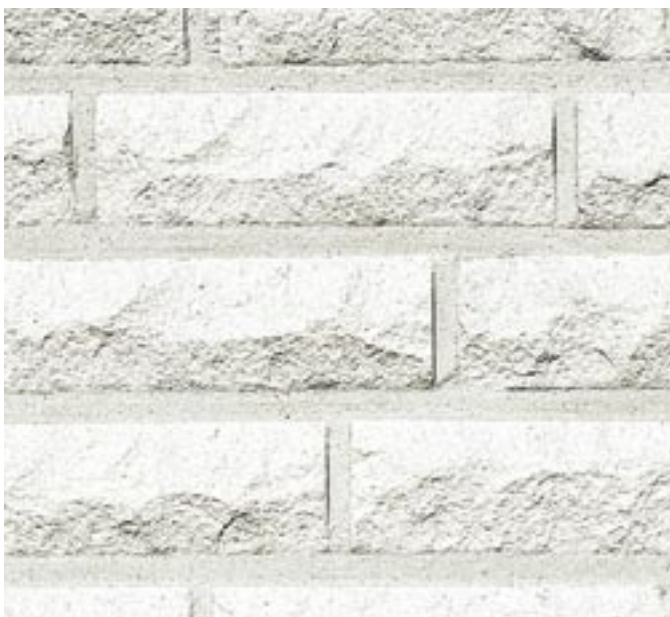
Bild 5: Sichtmauerwerk aus bossierten KS-Verblendern, Format NF, weißer Fugenmörtel
