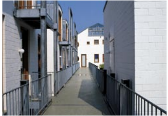
Bild 12: Sichtmauerwerk aus KS-Verblendern im Format 2 DF, weiß gestrichen
