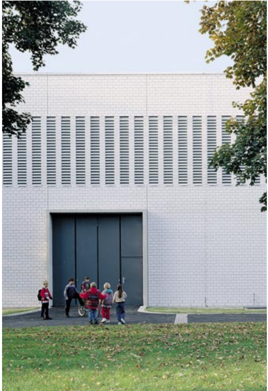
Bild 28: Sichtmauerwerk aus KS-Verblendern, farblos imprägniert, im Industriebau
