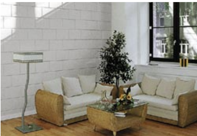
Bild 7: Innensichtmauerwerk aus KS-Fasensteinen, weiß gestrichen
