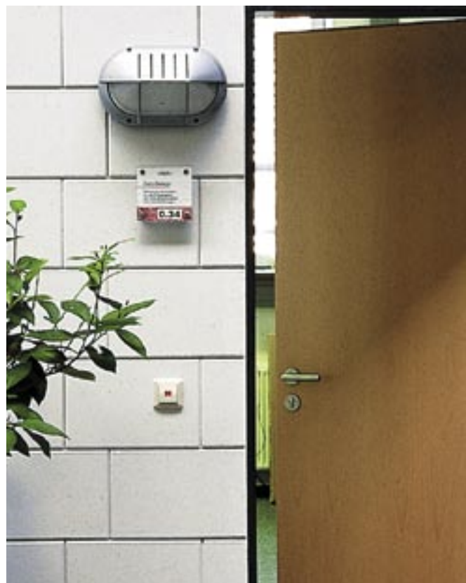
Bild 20: Innensichtmauerwerk aus KS-Fasensteinen, Installationen verdeckt in Kanälen
