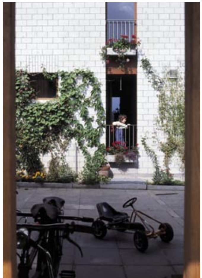
Bild 9: Sichtmauerwerk aus KS-Verblendern im Format 2 DF, farblos imprägniert, Mauerverband mit halbsteiniger Überdeckung
