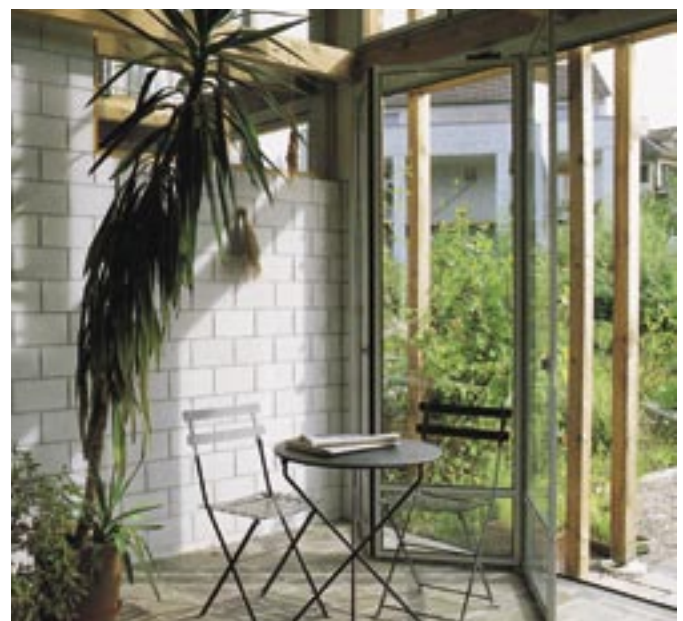
Bild 2: Innensichtmauerwerk aus KS-Verblendern
