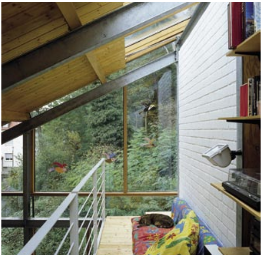
Bild 27: Innensichtmauerwerk aus KS-Steinen, weiß gestrichen
