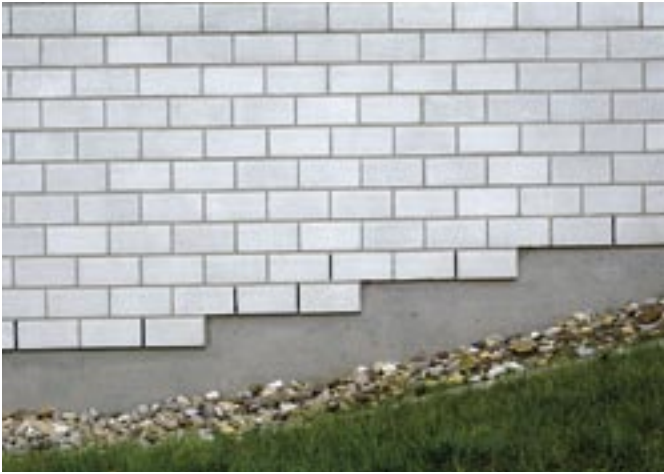
Bild 11: Sichtmauerwerk aus KS-Verblendern, farblos imprägniert, abgetreppter Sockelanschluss bei einem Gebäude in Hanglage
