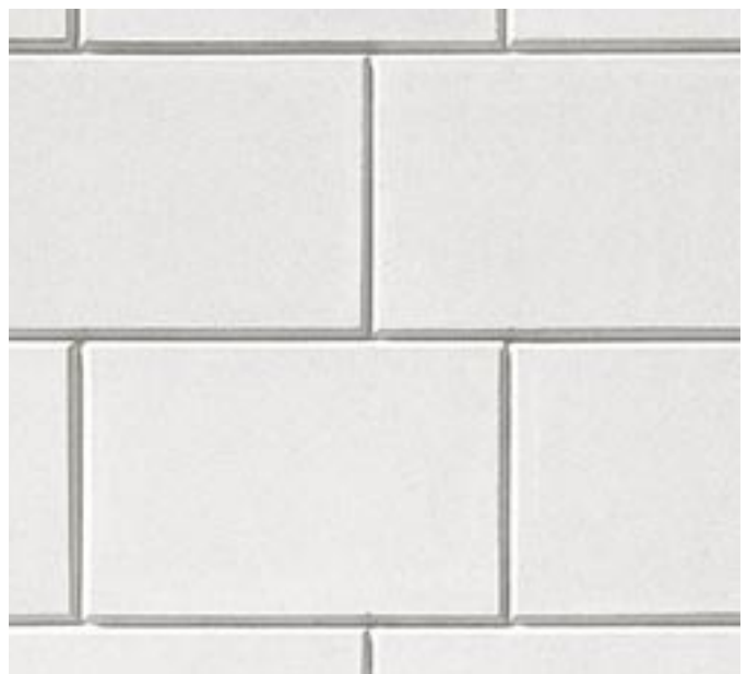
Bild 6: Sichtmauerwerk aus KS-Fasensteinen, außen in Verblenderqualität und mit vermörtelten Stoßfugen
