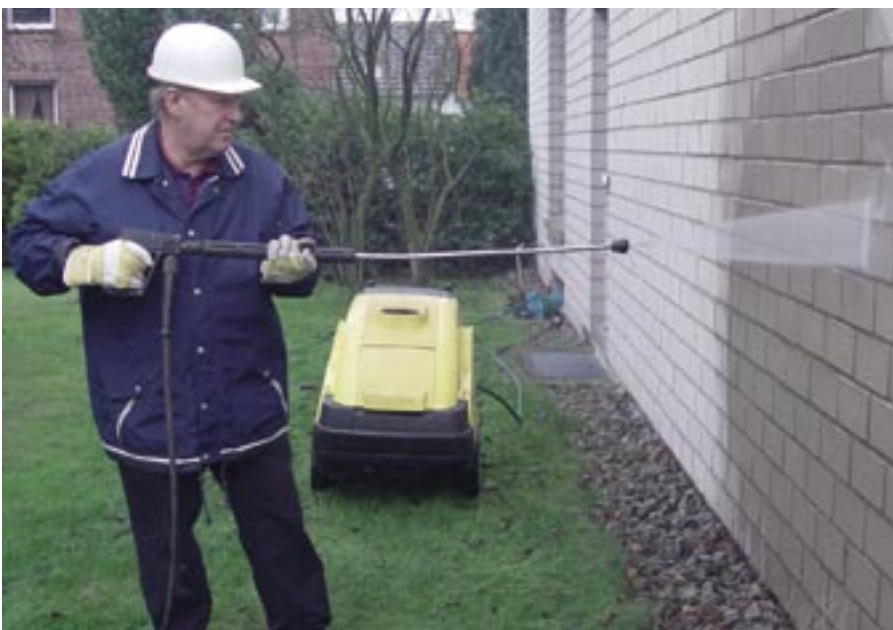
Bild 24: Reinigung mit Hochdruckdampfreiniger
