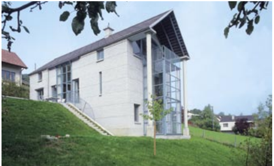
Bild 26: Sichtmauerwerk aus KS-Verblendern, farblos imprägniert
