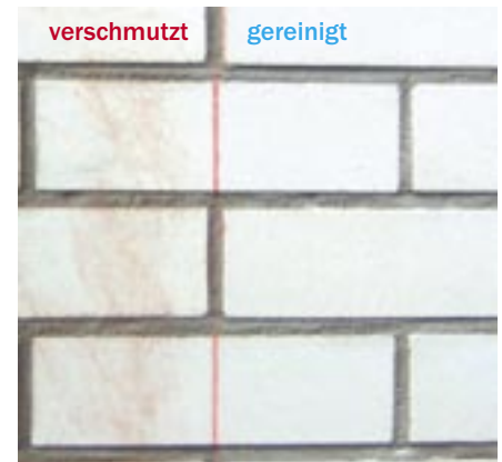
Bild 25: Reinigungseffekt, Beispiel Reinigung mit Schleifpapier, Körnung 140
