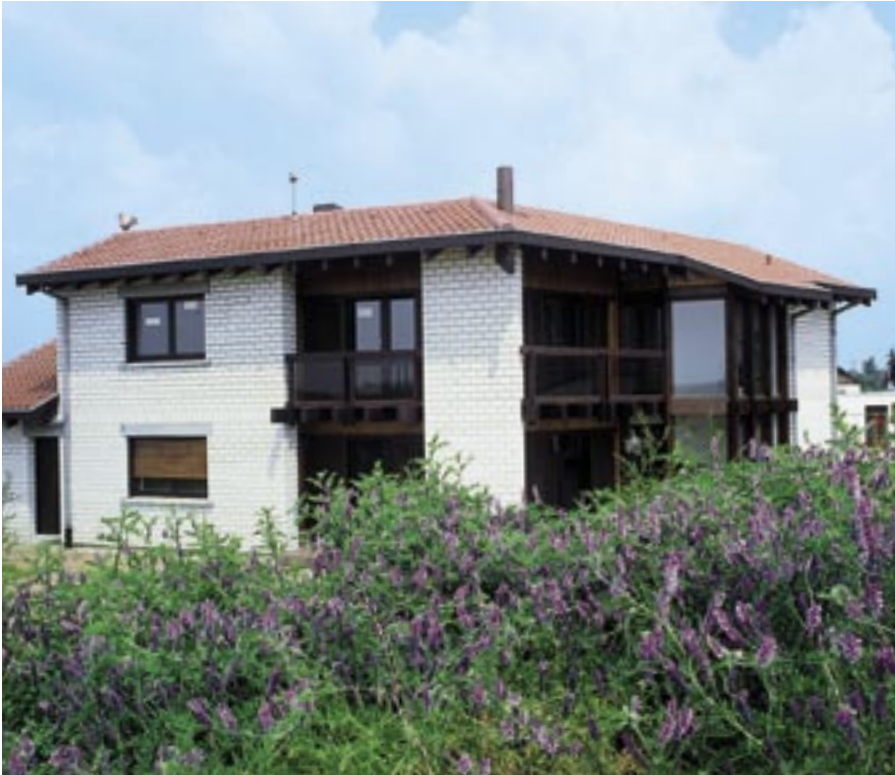
Bild 18: Sichtmauerwerk aus KS-Verblendern im Format 2 DF, farblos imprägniert
