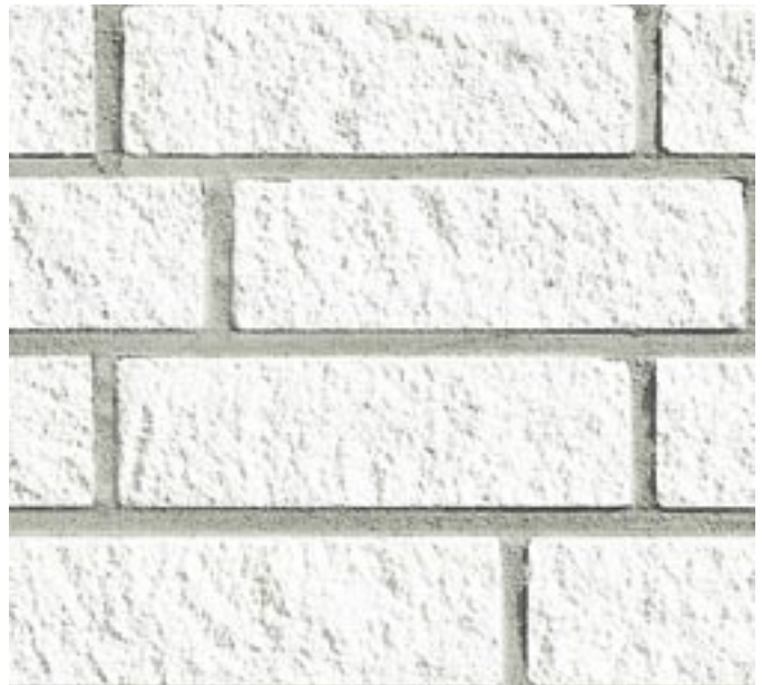
Bild 4: Sichtmauerwerk aus bruchrauen KS-Verblendern, Format NF
