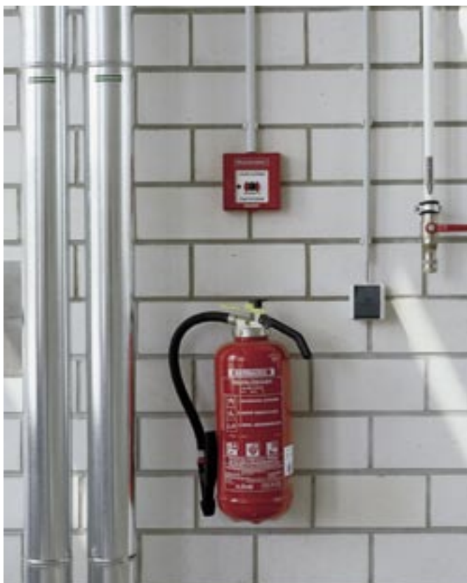
Bild 19: Innensichtmauerwerk aus KS-Steinen im Format 2 DF, Installationen freiliegend
