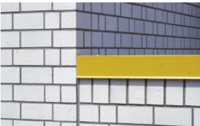
Bild 8: Sichtmauerwerk aus KS-Verblendern im Format 2 DF, farblos imprägniert, Mauerverband mit viertelsteiniger Überdeckung
