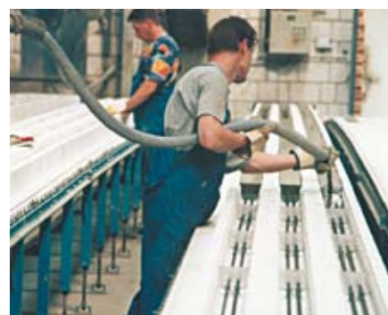
Bild 12: Verfüllen der KS-Sturzschalen.
