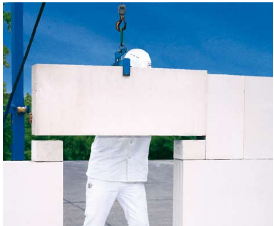
Bild 22: Einbau eines KS-Fertigteilsturzes (FTS) nach abZ Z-17.1-621.
