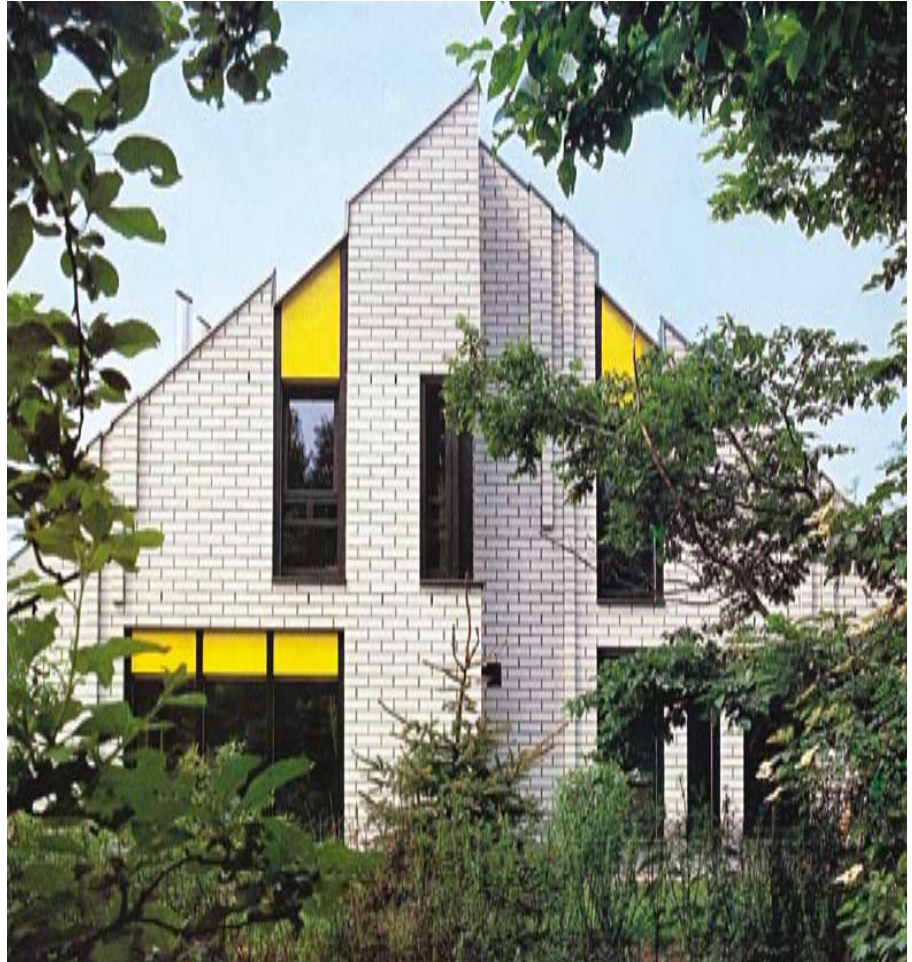
Bild 1: KS-Sichtmauerwerk-Fassade mit eingebauten KS-Sichtmauerstürzen.
