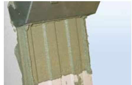
Bild 18: Stoßfugenvermörtelung mit einer geeigneten Stoßfugenkelle.
