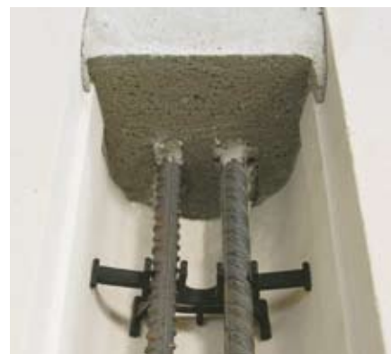
Bild 14: Zuggurt-Bewehrung mit Abstandhalter.
