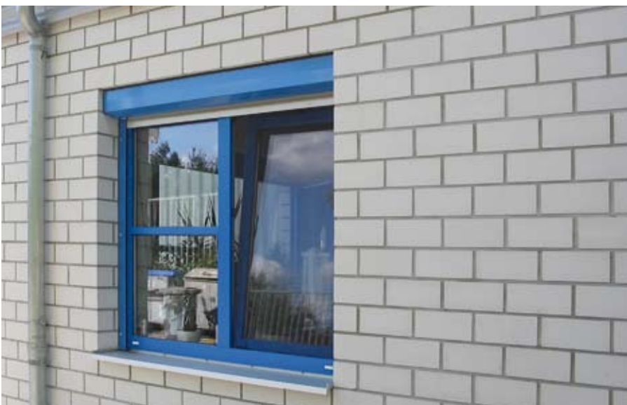
Bild 26: Fassade und KS-Sichtmauersturz bilden eine ästhetische Einheit.
