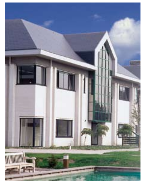
Bild 27: Fassade aus KS-Sichtmauerwerk.
