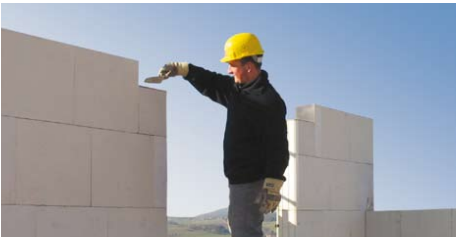
Bild 15: Vorbereiten des Sturzauflegers.
