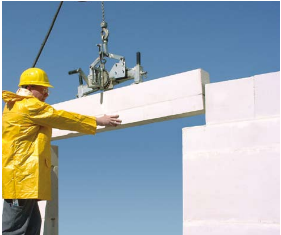
Bild 21: Einbau eines KS-Fertigteilsturzes (FTS) nach abZ Z-17.1-774.
