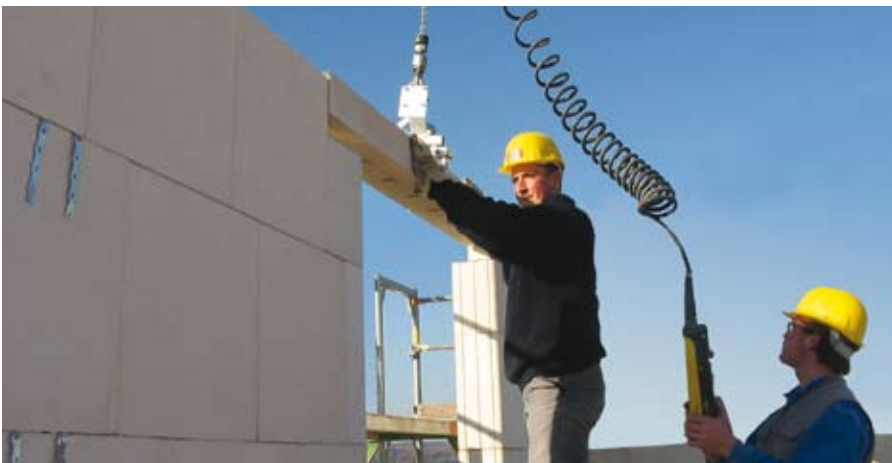
Bild 16: Einbau eines KS-Flachsturzes mit Versetzhilfe.
