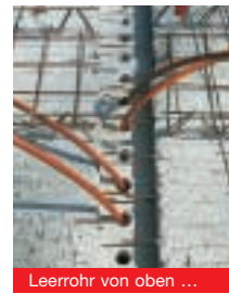
Leerrohr von oben ...
