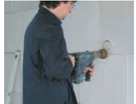
Im Installationsplan vorgesehene Dosen mit Kronenbohrer aufbohren
