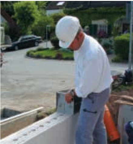
Dünnbettmörtel mit dem Mörtelschlitten aufziehen
