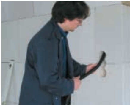
VDE-Installationsrohr oder NYY-Leitungen 1 in die freigegebenen KS-Quadro E Kanäle einführen 2
