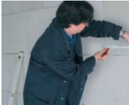
Vor Ort nach Plan Schalter, Steckdosen und Verteiler einmessen und anzeichnen
