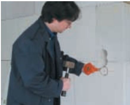
Bohrkerne herauslösen
