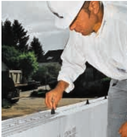
Zentrierhilfen aufstecken
