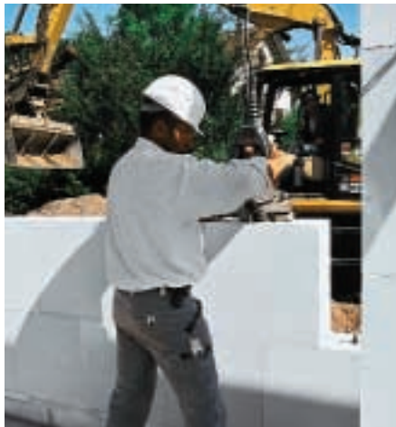
... ausrichten und in den Dünnbettmörtel absetzen
