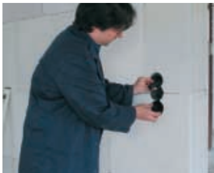
Einsetzen der Schalter-, Steck- und Verteilerdosen
