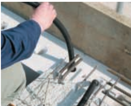
Weitere Installationsrohre und Leitungen werden nach dem selben Verfahren zügig eingezogen und verlegt
