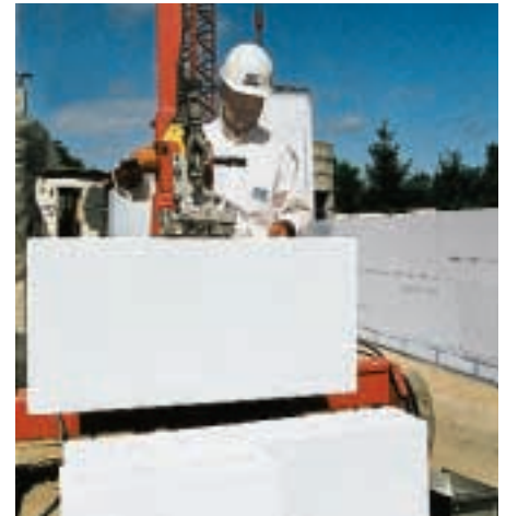
KS-Quadro E mit dem Versetzgerät aufnehmen ...
