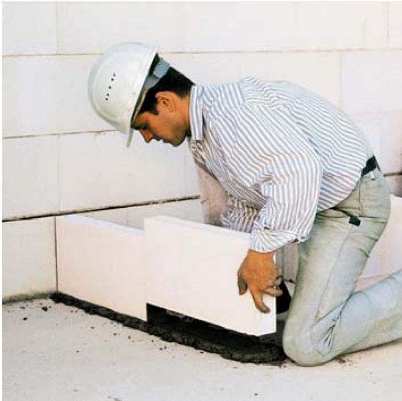
Bild 5.2: Schwere Trennwand aus Kalksandstein (aus: "Kalksandstein-Infos")
