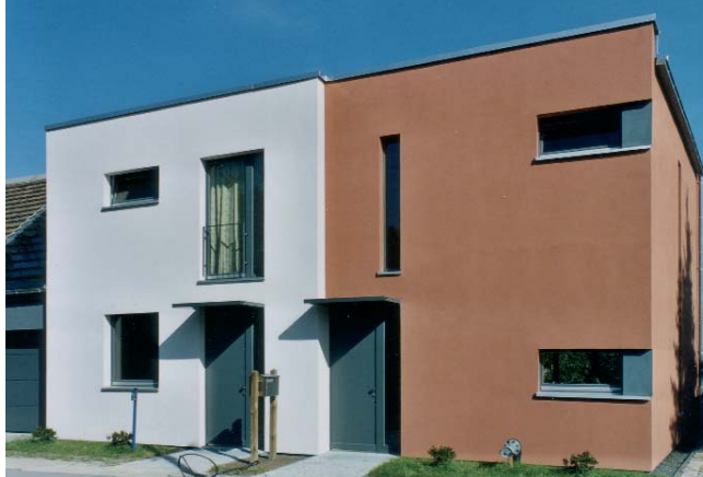
Architekt Beyer teilte das Gebäude in drei Baukörper. Garage (rechts – kaum zu sehen), Haupthaus (in der Mitte), Einliegerwohnung (links). Die gleiche Bauhöhe und gleiche Fassadenart (Wärmedämmverbundsystem) bringen Ruhe in das Ensemble. Die Einliegerwohnung ist ein völlig selbstständiger Bereich mit eigenem Zugang und eigenem Garten. Foto: Spindler/Lindner
