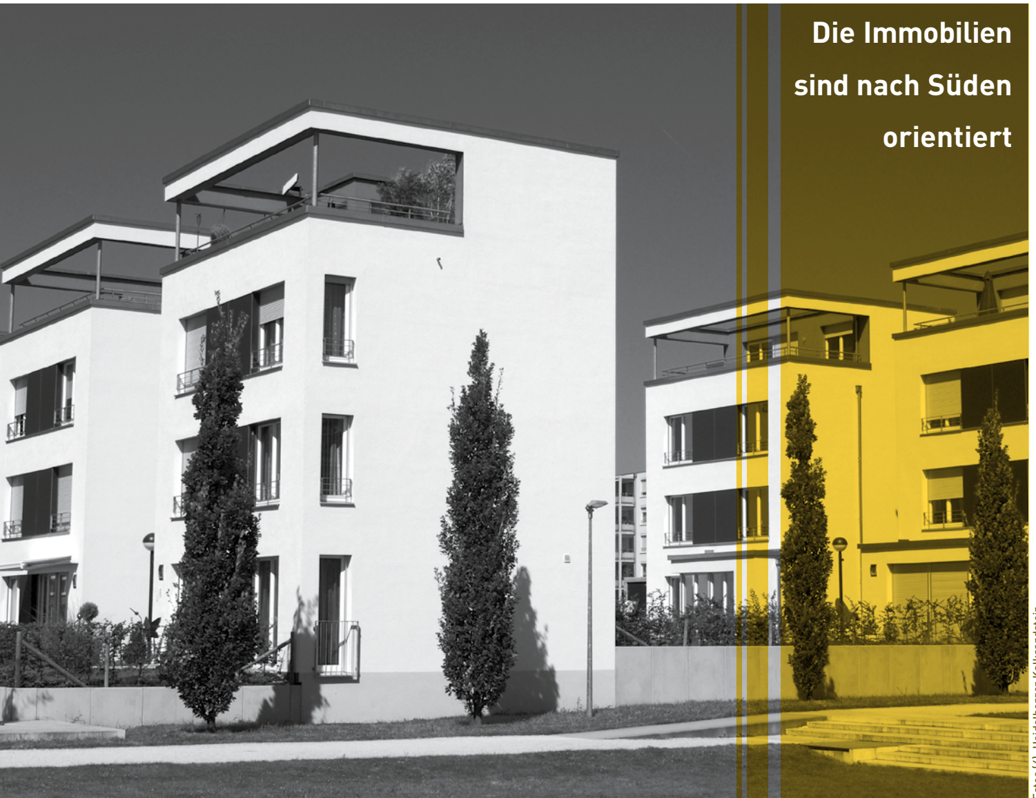
Fotos (4): Heidelberger Kalksandstein
