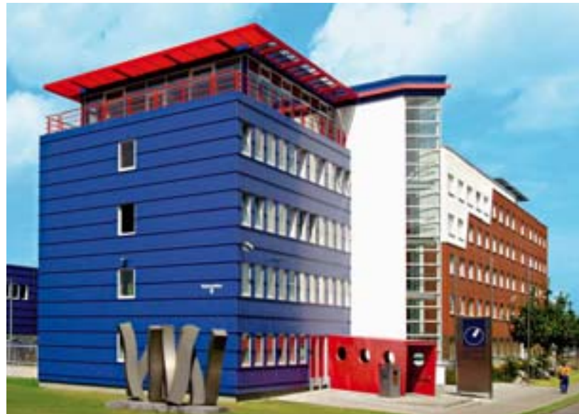
Gebäudeansicht von Süden.
